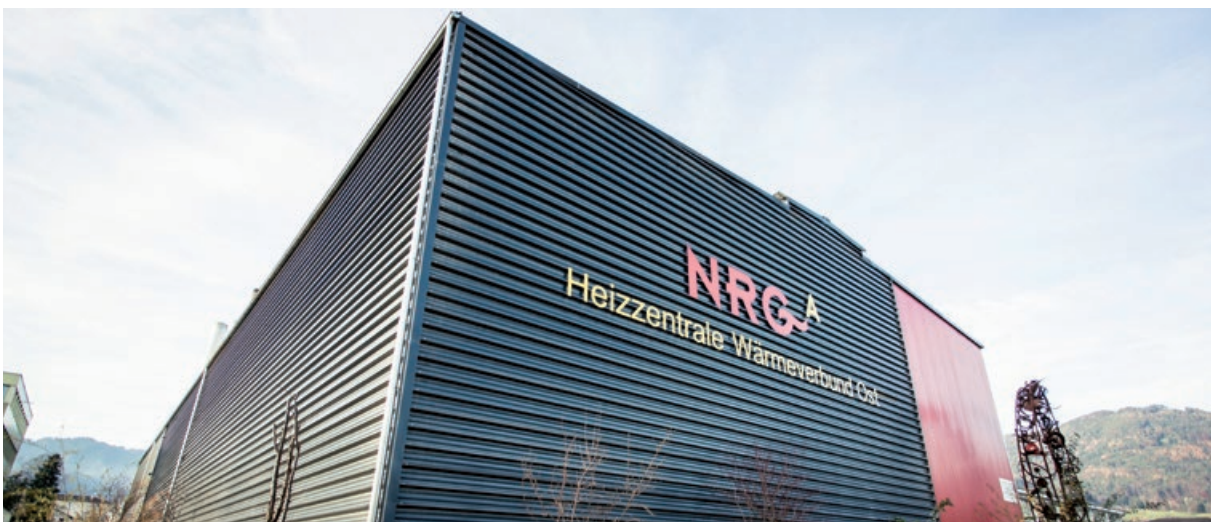
Die Heizzentrale der NRG A AG in St.Galler Rheintal. Bild: NRG A AG
